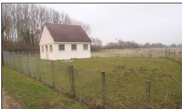
Station de pompage de Guiscard
